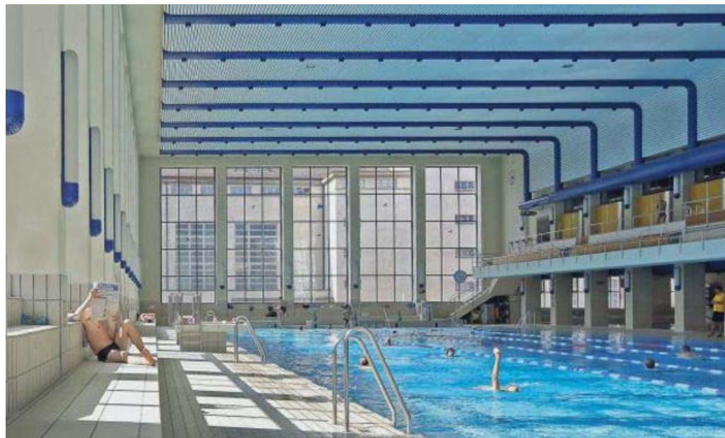
Der Countdown läuft im City: Von Mai 2010 bis Sommer 2012 wird das Hallenbad umfassend saniert. Bild: Nicola Pitaro
